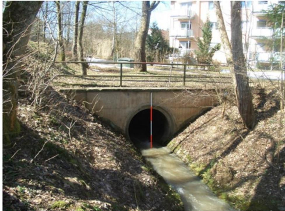
Abbildung 2: Verdolungseinlauf (Bild von der HWGK-Vermessung 2006)
