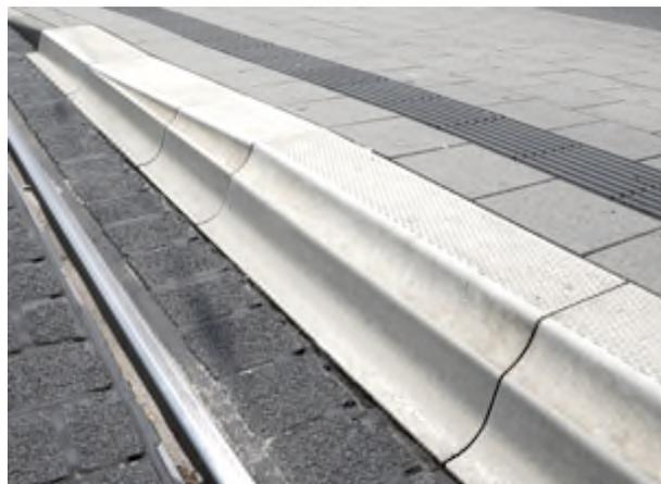
Um den barrierefreien Einstieg in den Bus zu ermöglichen soll ein Kasseler Bord in der Höhe von 21cm und der Länge von 15m angebracht werden. Schleppkurven haben gezeigt, dass der Bus an dieser Stelle und bei der derzeitigen Form der Haltestelle als Bucht, über das nun zu hohe Bord fahren müsste. Aus diesem Grund soll die Haltestelle nun als Kap funktionieren, dessen Rand bis an den durchgehenden Fahrstreifen des Straßenverkehrs bzw. an den
